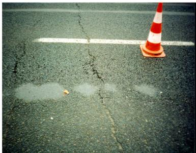
Grosse fissure nécessitant un traitement particulier par fraisage préalable
