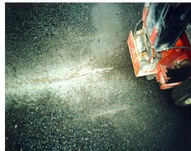
Fissure fraisée prête à être nettoyée et colmatée
