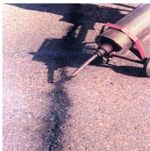
Nettoyage de la fissure à l'aide d'une lance thermopneumatique
