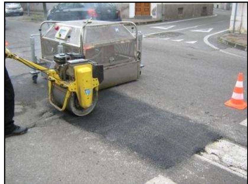
Nivelage et compactage
