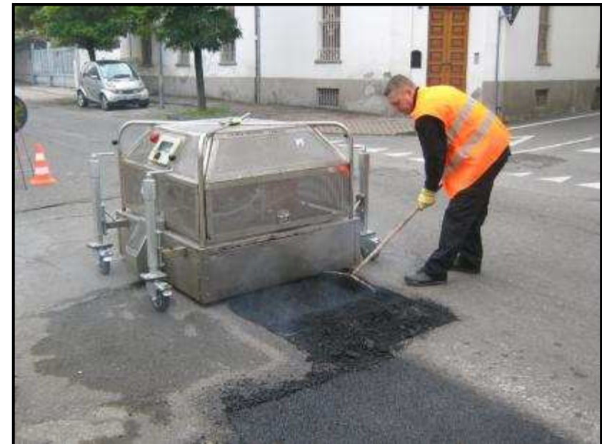
Mélange de l'enrobé existant chaud
