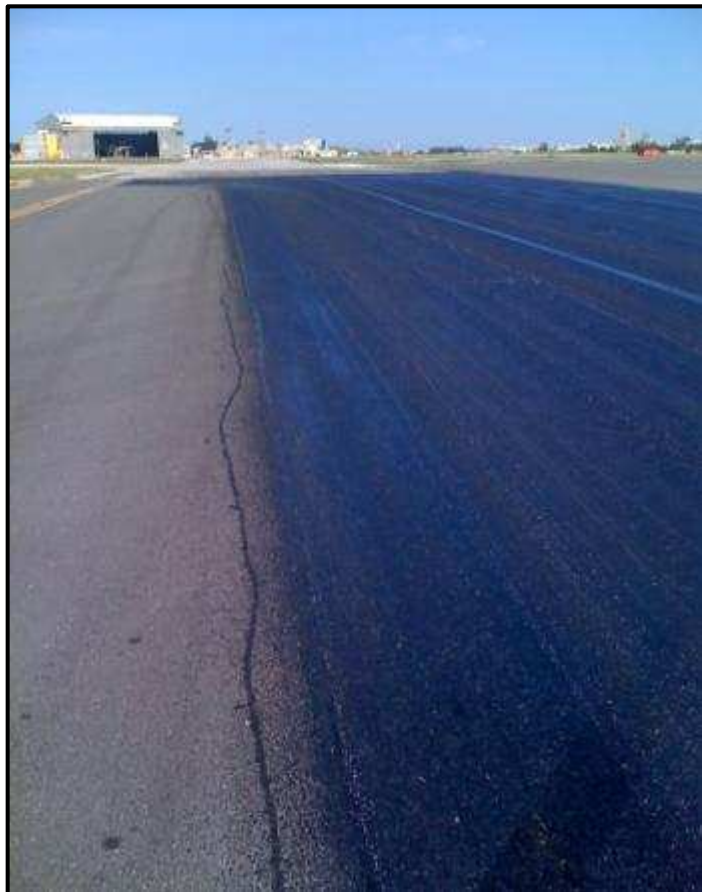
Condition de l'enrobé après l'application du Rhinophalt
